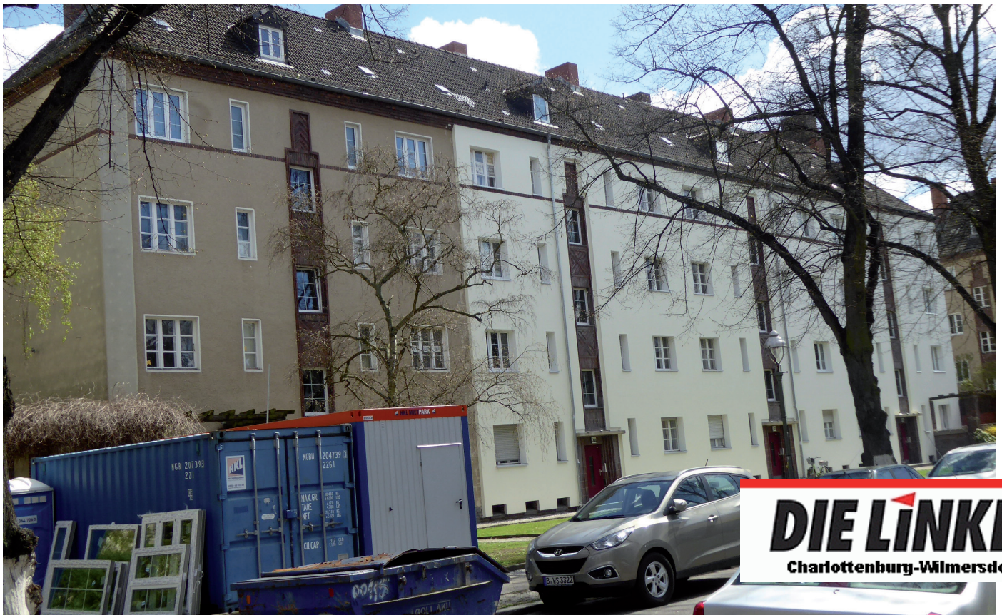
Häuser der Vonovia in Schmagendorf: Die Sanierung hatte schon begonnen ...
