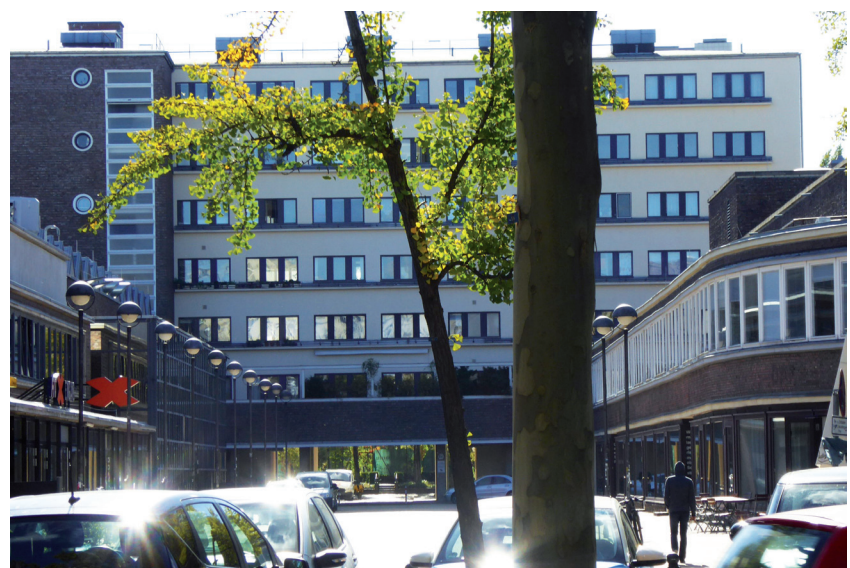
Vorderansicht des WOGA Komplexes mit der Schaubühne, die ebenfalls zum Gebäudeensemble gehört. Im heutigen Theater befand sich ursprünglich das Premierenkino UNIVERSUM, Copyright/Foto: DIE LINKE/H.B.
